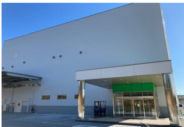
建設中の工場エントランス
